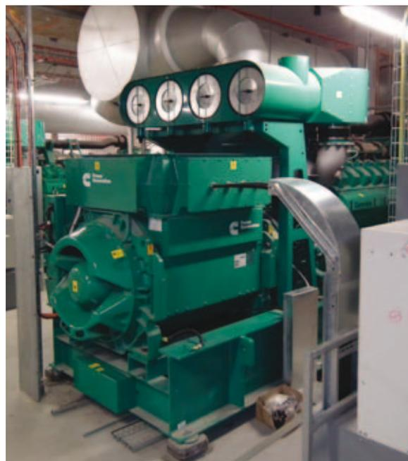
**Cummins установили ТЭЦ на флагманской больнице под названием Royal North Shore расположенная в Сиднее, Австралия. Электростанция обеспечивает базовую мощность в 4 МВт при пиковой нагрузке, соответствуя требованиям клиента по низкой стоимости и высокому КПД при выбросах оксидов азота меньше чем 250мг/ММЗ**
